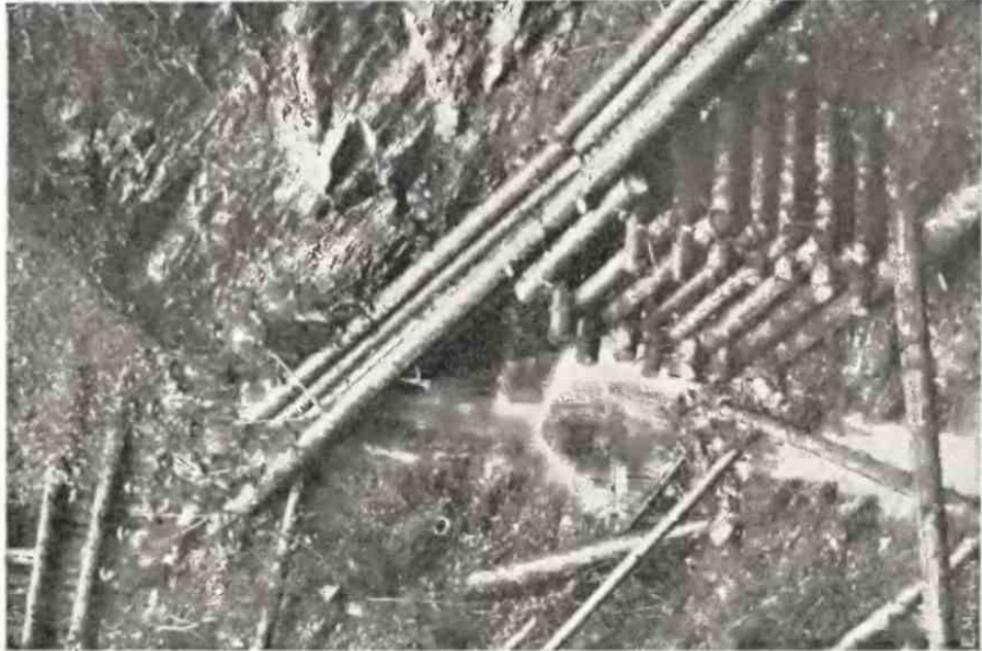
Scoc uscat și scoc cu apă în Carpații Păduroși (Maramureș, Valea Râului). Glissoir sec et glissoir humide dans les Carpates de Maramureș (Valea Râului). Trocken- und Wasserriese in den Waldkarpathen (Maramureș, Valea Râului).
