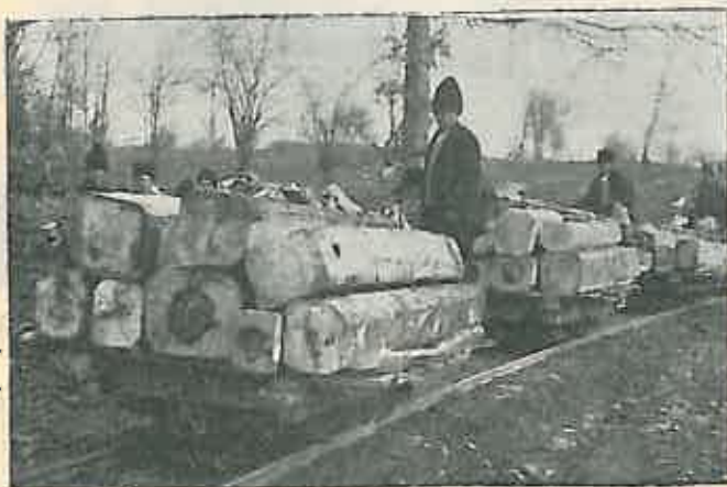
Fig. 3. — Transportul traverselor pe vagonete.
