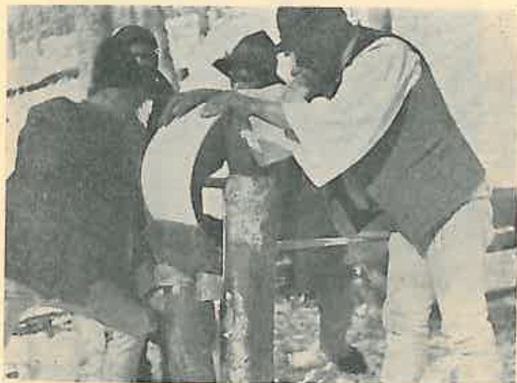
Fig. 3. — Așchia este băgată în teșghea, de unde este scoasă colac.
