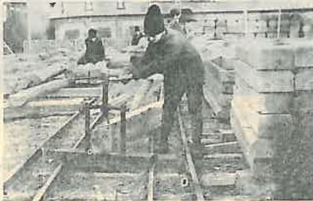
Fig. 5. — Presa ajutătoare pentru aplicat scoabele.
