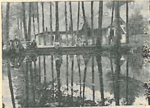
Cantonul Comarnic (Oc. silv. Reșița).
