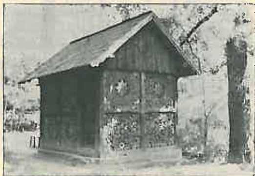
Coliba de adăpost „Medreș” (Oc. silv. Bocșa-Montană).
