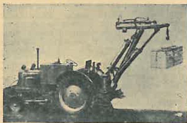
Fig. 2. Excavatorul E-153, folosit ca macara.
