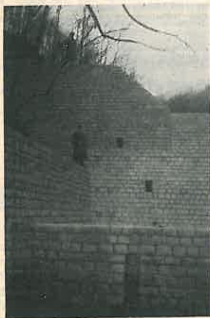
Fig. 3. Barajele de dimensiuni mari, amplasate la gura torenților, nu rezolvă în mod convenabil problema reținerii aluviunilor și prin volumul lor mare de zidărie, sînt neeconomice. În fotografie, barajul nr. 2 (vedere parțială), construit în anul 1958 la torentul Secăria, afluent al văii Dof-tana, regiunea Ploiești, pentru apărarea c.f.f.
