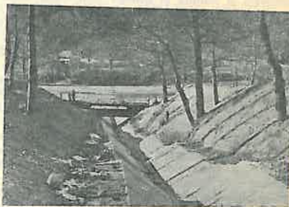
Fig. 2. Canal de scurgere de pe lorentul Valea Bărbuleasca — perimetrul de ameliorare Berevoești — din bazinul Argeș, pentru protecția c.f.f. Stîlpeni-Rîușor. Canalul a fost executat de către D.R.E.F. Pitești, prin Grupul de șantiere de corectarea torcenților Rm. Vilcea (foto: ing. I. Tăbăcaru).
