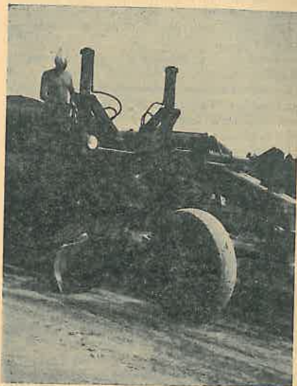
Fig. 8. Nivelarea platformei drumului cu ajutorul unui greder.
