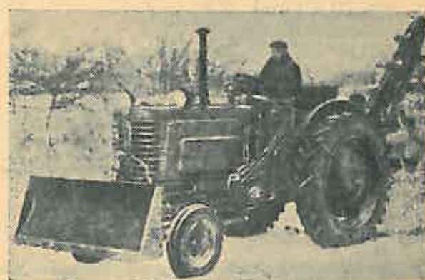
Fig. 3. Excavatorul E-153 cu echipament de lucru pentru executat șanțuri.
