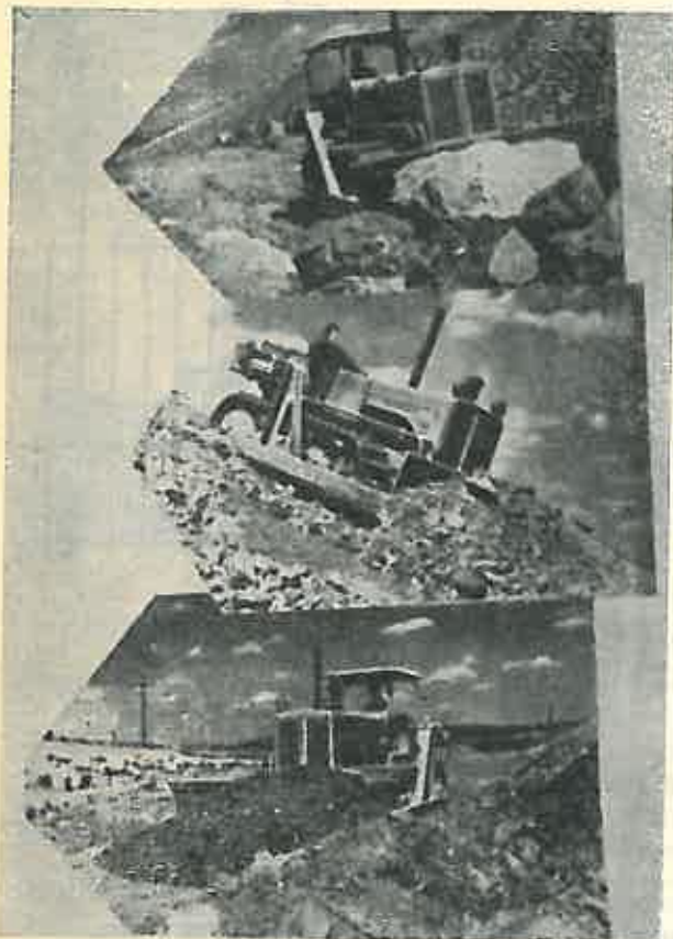
Fig. 5. Tildozor cu comandă hidraulică executând diferite lucrări de terasamente.
