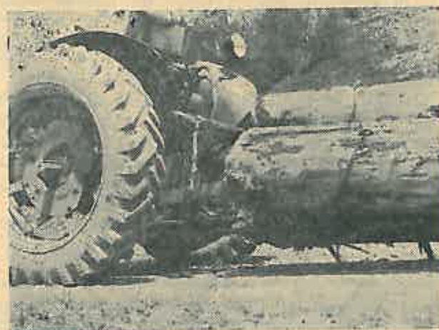
Fig. 2. Modul de prindere a buștenilor cu ajutorul cablurilor, la trasul prin semitirire, cu tractorul Universal-26, din parchetul Valea Șimonului, sectorul de exploatare Rîșnov.
