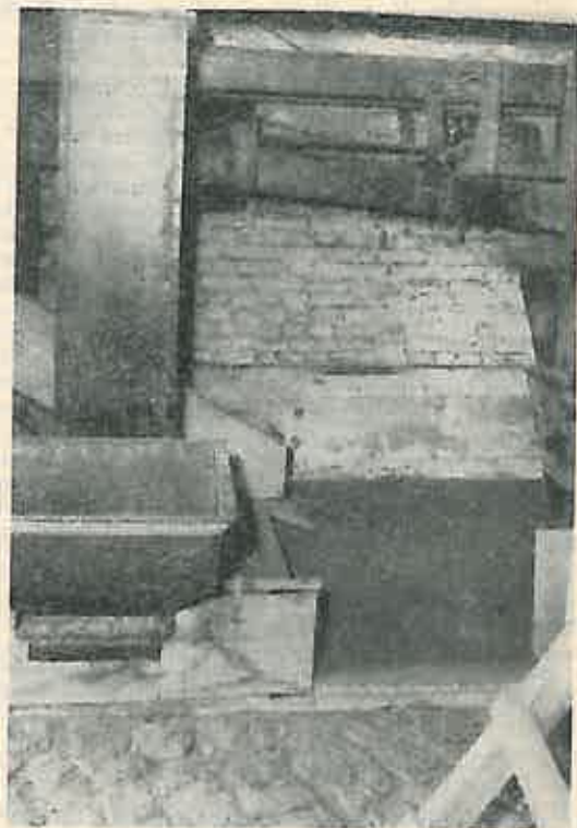
Fig. 1. În față la stînga, gura de alimentare cu conuri (oreca mică) cu elevator, care reparțizează uniform conurile și le transportă pe grătarul oscilant din spate (uscătorie Jatznick).
