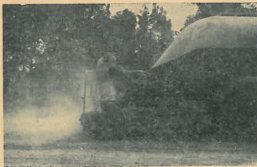
Fig. 6. Mașina de împrăștiat ciment.
