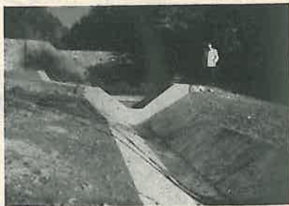
Fig. 4. Barajele mici, împletite în mod judicios cu vegetația din bazinele de recepție, urmate în partea inferioară de canale de scurgere, sînt mai economice, au o eficiență tehnică mai mare și apără mai bine diferitele obiective care trebuie protejate. În fotografie, un canal de scurgere construit în anul 1959 pe Valea Lacului din perimetrul de ameliorare Berevoești, pentru protejarea c.f.l. Brătia, regiunea Pitești.
