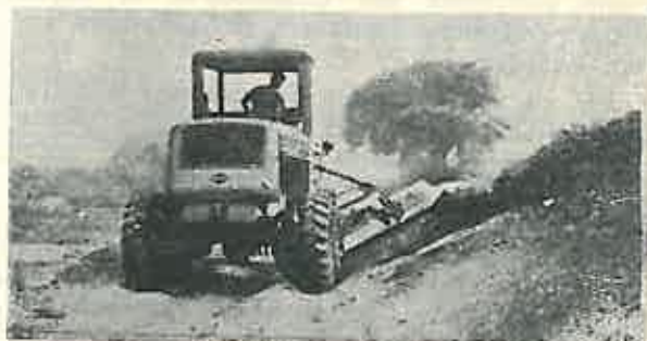
Fig. 6. Greder executînd lucrări de taluzare.
