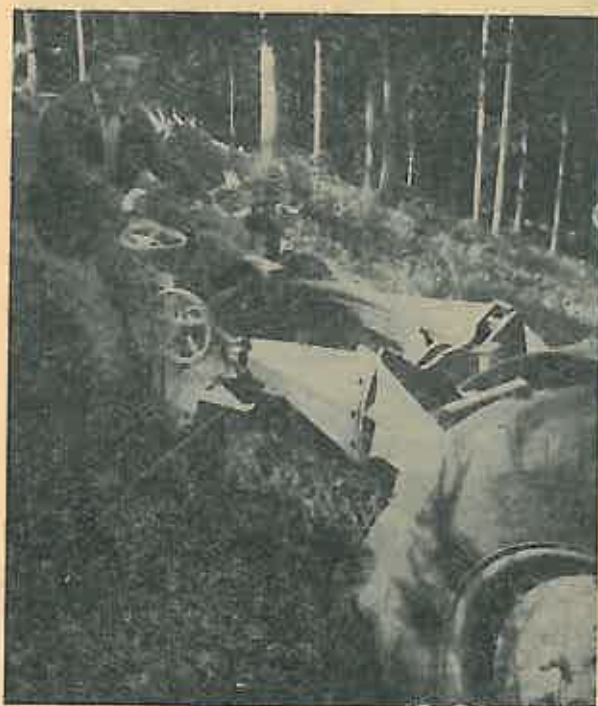
Fig. 5. Mașina de nivelat, construită de Stațiunea experimentală CSAZV, destinată pentru întreținerea drumurilor forestiere.
