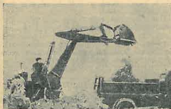
Fig. 8. Excavatorul E-221 folosit la săpat-încărcat în mijloace de transport.
