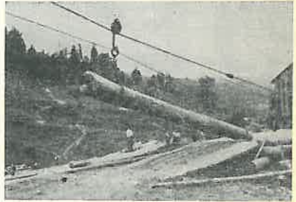
Fig. 2. Transportul lemnului cu funicularul în cadrul I.F. Intorsura Buzăului (Foto: V. Petcu).
