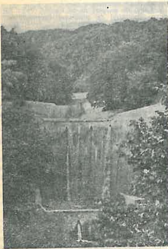
Fig. 3. Sistem de baraje de retenție, de mare randament, executate de către D.R.E.F. Ploiești prin Grupul de șantier de corectarea torenților Sinaia, pe Valea Conciului, în perimetrul de ameliorare Posada (foto: ing. A. Costin).
