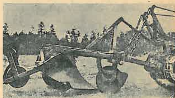
Fig. 2. Plug forestier combinat PKL-70, cu dispozitiv de semănat.
