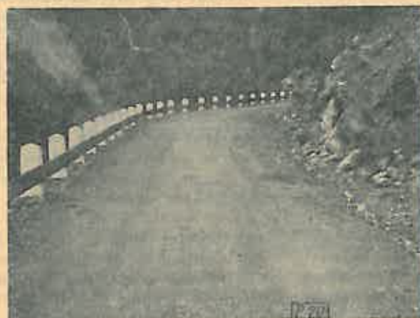
Fig. 2. Drumul autoforestier „Plopii”, construit în regiune în anul 1960 de către I. F. Curtea de Argeș, D.R.E.F. Argeș.
