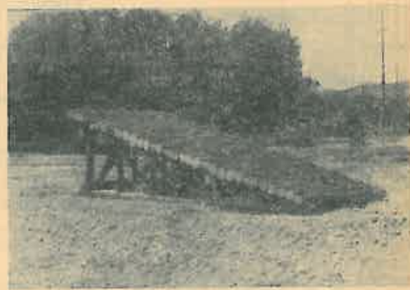
Fig. 1. Vedere de ansamblu a estacadei.
