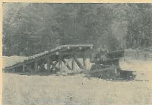
Fig. 3. Transportul estacadei cu buldozerul la locul de încărcare.
