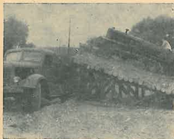
Fig. 4. Încărcarea balastului cu buldozerul în autobasculantă (vedere laterală).
