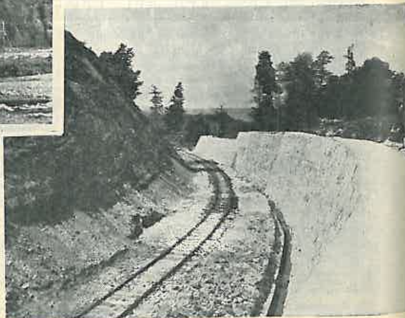
Zid de sprijin pe linia c.f.f. Curtea de Argeș — Bahna din raza D.R.E.F. Argeș
