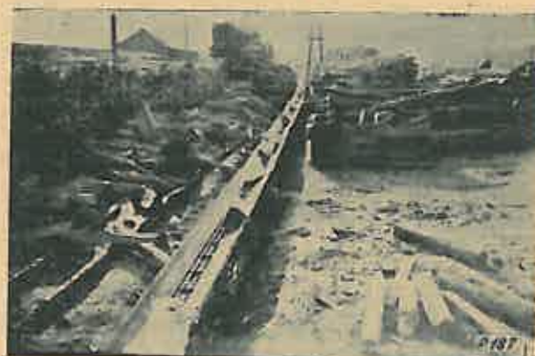
Fig. 8. Transportul lemnului despicat în interiorul depozitului cu ajutorul transportoarelor TLF-5.
