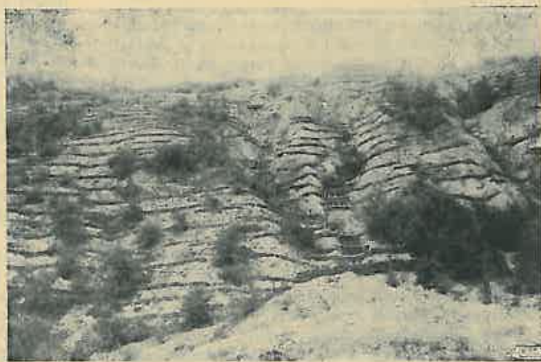
Fig. 8. Cleionajele, gărdulețele și lucrările de împăduriri, ca cele construite în perimetrul Dîrțu de pe Valea Bistriței, contribuie substanțial la reținerea și fixarea aluviunilor în bazinele torențiale.
