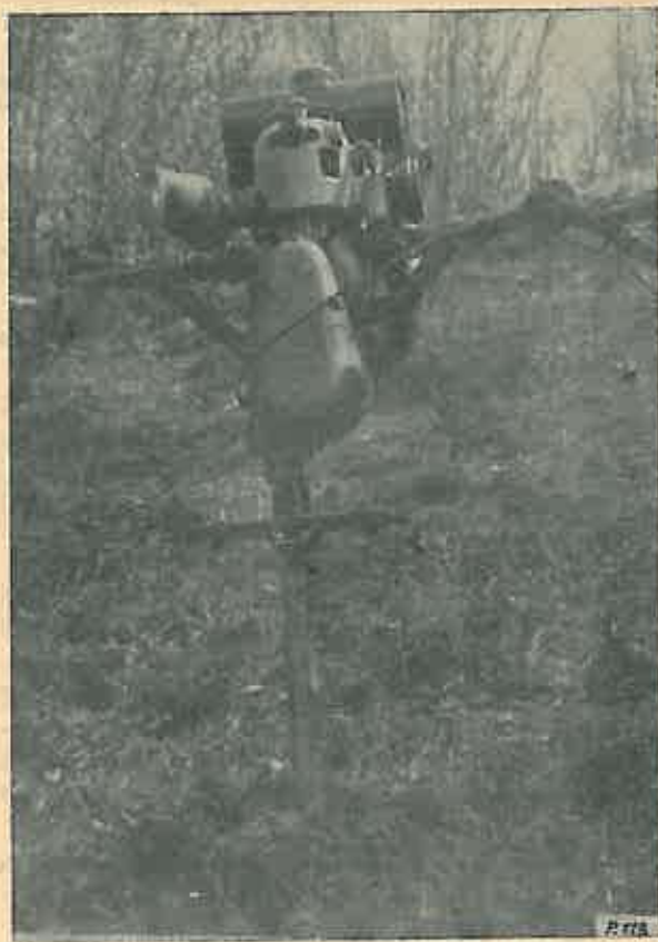
Fig. 3. Burghiul mecanic Wühlmaus adaptat pentru burghie spirale.
