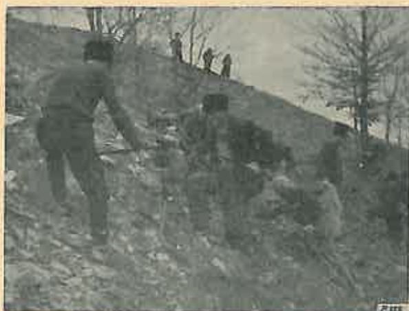
Fig. 7. Burghiul mecanic Wühlmaus adaptat, în lucru, pe terenuri degradate cu fragmente de rocă la suprafață, perimetrul de ameliorare Valea Sării (Vrancea).
