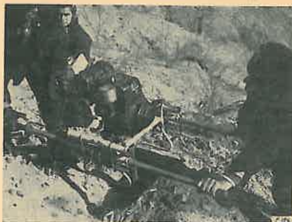
Fig. 9. Mărunțirea pămîntului în terenurile marnoase, cu umiditate scăzută, folosind burghiul mecanic Gribor. Perimetrul de ameliorare Valea Sării-Saune (Vrancea).
