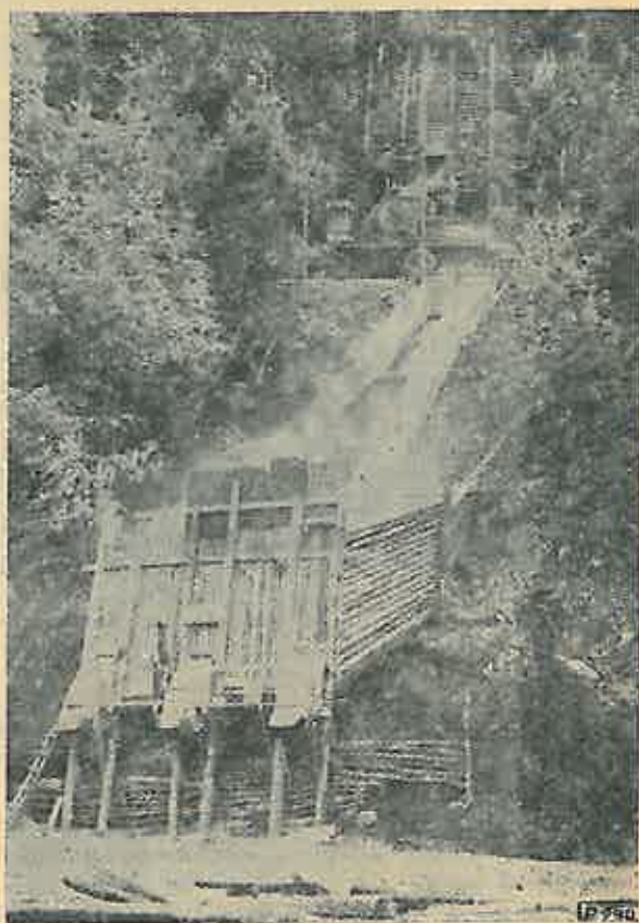
Fig. 3. Buncăre construite pentru alimentarea concasorului și pentru evacuarea pietrei sparte.
