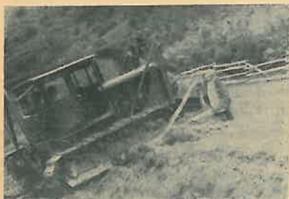
Fig. 2. Buldozer executând taluzarea la drumul forestier R. Muz—Cugir (august 1960).
