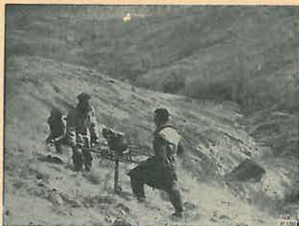
Fig. 5. Aspect din perimetrul de ameliorare Colaeu (Vrancea). Burghiul mecanic Gribor in lucru.
