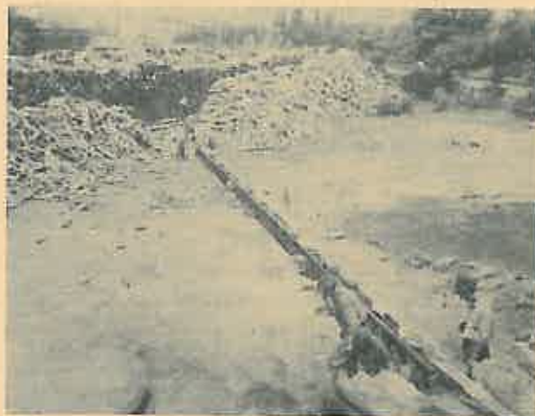
Fig. 7. Deplasarea lobdelor cu transportorul în vederea stivuirii pentru stocaj.
