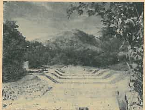
Fig. 5. Canal de scurgere al torențului Pîntești-Sălciua.
