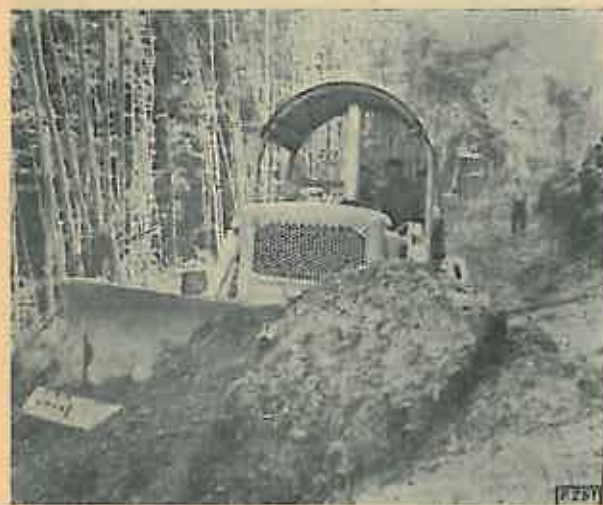
Fig. 4. Executarea platformei cu ajutorul buldozerului universal de mare putere la drumul auto forestier Ghimbav.
