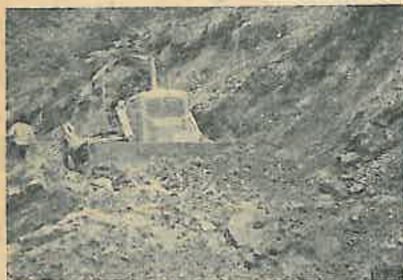
Fig. 1. Buldozer universal de mare putere folosit la lucrările de terasamente la drumul auto forestier Dimbovița.
