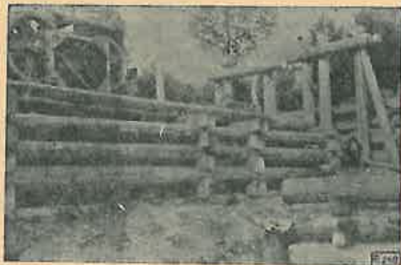
Fig. 2. Stația de descărcare a funicularului cu stația intermediară pilon din exploatarea Vișinul, sectorul Valea Lupului din I.F. Curtea de Argeș.
