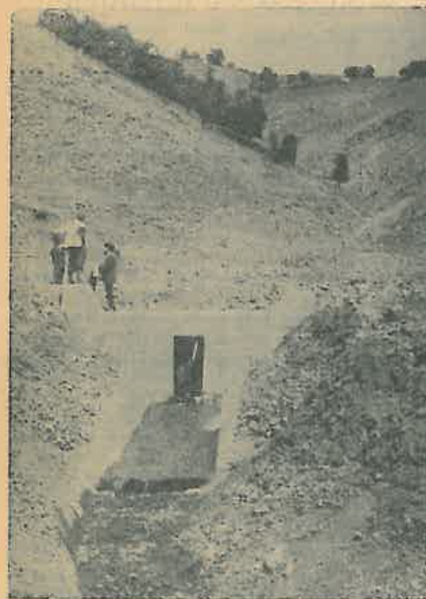
Fig. 1. Barajul-dren, sistem Rosić, cu un canal-dren. (Foto: ing. Tr. Mecold)
