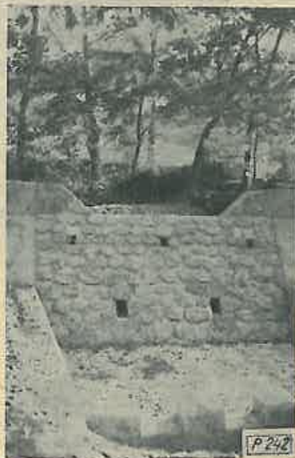
Fig. 2. Barajul construit în anul 1959 pe torențul din Vatea Turnului din perimetrul Berevoești, care, alături de împăduririle executate în bazinul de recepție, contribuie la stăvillirea transportului de aluviuni.
