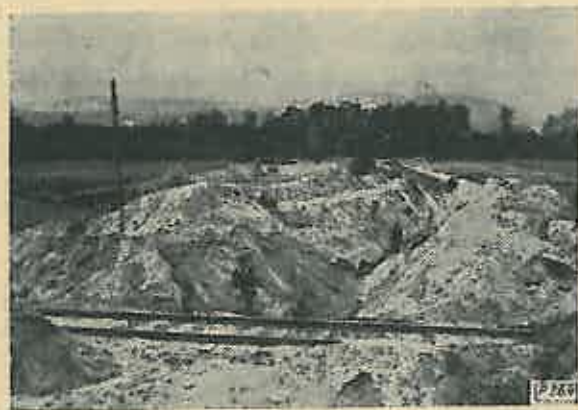
Fig. 1. Aspect din perimetrul de ameliorare Minicești (bazinul Argeș) înainte de executarea lucrărilor de corectare a torenților.
