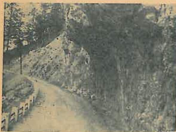
Fig. 1. Drumul auto forestier în semibolta de pe valea Oltețului, lucrat prin derocare.
