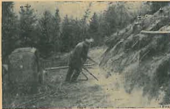
Fig. 4. Motocompressoare dotate cu cîte două burghie, folosite la execuția forajului pentru săpături în stîncă
