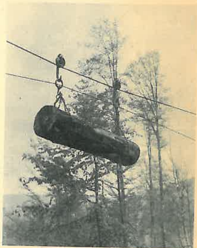
Funicularul Mineciu transportând bușteni de fag din Sectorul de exploatare Valea Brazilor, parchetul Poarta oșie I.F. Sighet.
