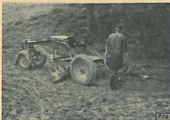
Fig. 2. Greder tractat, folosit la construcția drumurilor forestiere.
