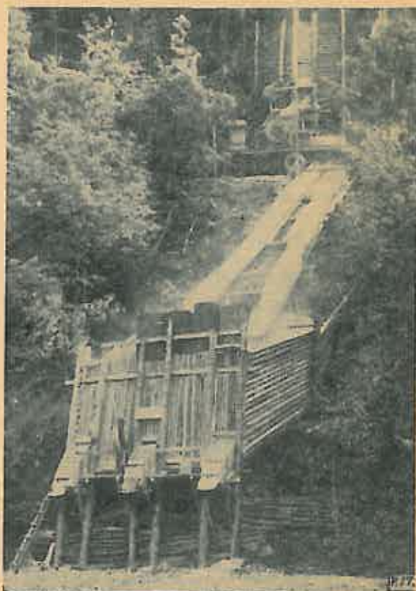
Fig. 1. Stația de concasare de la drumul auto forestier de pe valea Dimboviței, unde alimentarea cu piatră, evacuarea și încărcarea se realizează prin cădere proprie.
