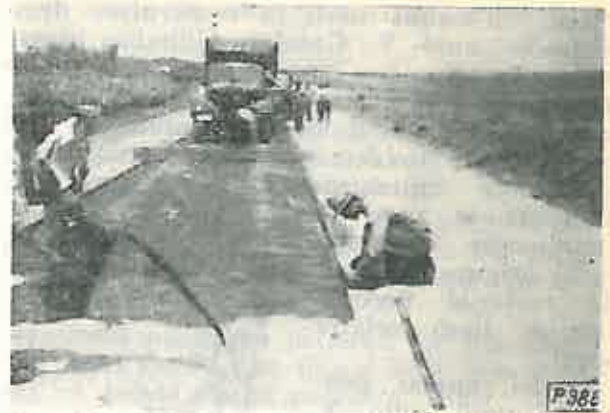
Fig. 11. Amorsarea cu bitum și aplicarea tratamentului superficial.
