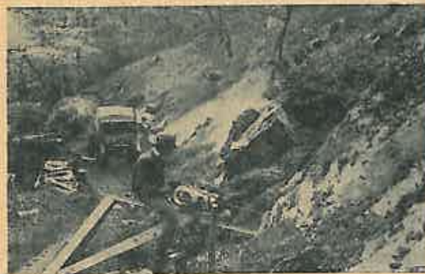
Fig. 5. Motoperforator dotat cu motor cu explozie este manipulat de un singur om și se poate utiliza cu succes în locurile greu accesibile pentru motocompressoare
