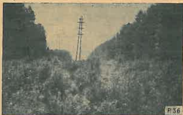
Fig. 1. Linia de 110 kV Borzești-Roman, D.R.E.F. Bacău, U.P.VIII — Fintinele, u.a. 12 și 5; lățimea culoarului — 60 m; înălțimea arboretului — 25 m; lungimea traversei D — 7 m. Defrișat în 1956, coridorul este acoperit în prezent cu ruți de plop și salcie căprească, deși arboretul natural este de fag pur și are 70 de ani.
