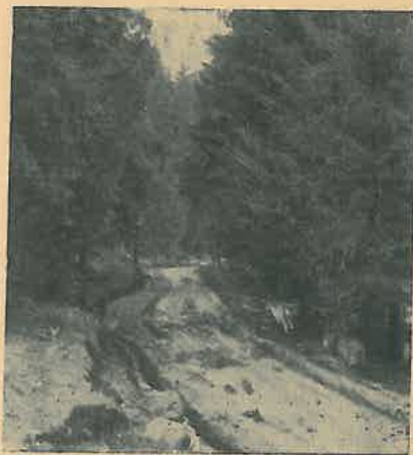
Fig. 1. Drum forestier auto de vale, neterminat, împletit superficial, dat provizoriu în exploatare, la care arborii marginali au oprit uscarea corpului şoselei.
