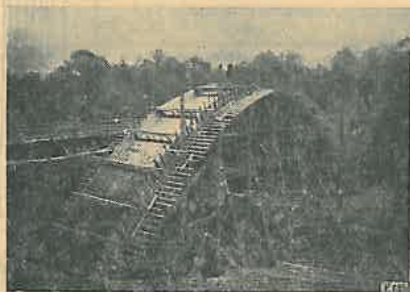
Fig. 4. Cintrile de susținere a bolților, în faza de execuție la podul c.f.f. Armeniș.
