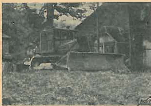
Fig. 1. Pentru construcția terasamentelor se folosesc buldozere. În fotografie, un buldozer montat pe tractor S-100.
