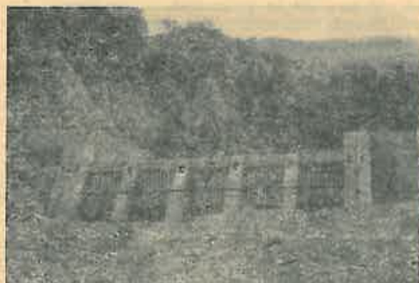
Fig. 6. Barajul filtrant de beton armat pe contraforți, executat experimental, în anul 1961, pe torentul Ghimpoasa, perimetrul de ameliorare Doftana II, Regiunea Ploiești: a — partea centrală deversată; b — partea centrală nedeversată; c — părțile laterale de încastare în maluri; d — grinzi orizontale; e — contraforți; f — montanți verticali. (Foto: ing. Traian Mecoță, 1961)
