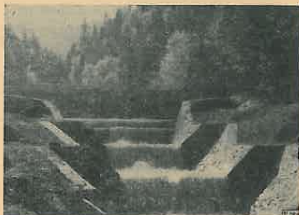
Fig. 1. Baraj din zidărie de piatră cu mortar de ciment, executat de DREF Ploiești prin grupul de șantier Sinaia, în perimetrul de corectare a torenților Unghia Mică — Valea Azugăi.
