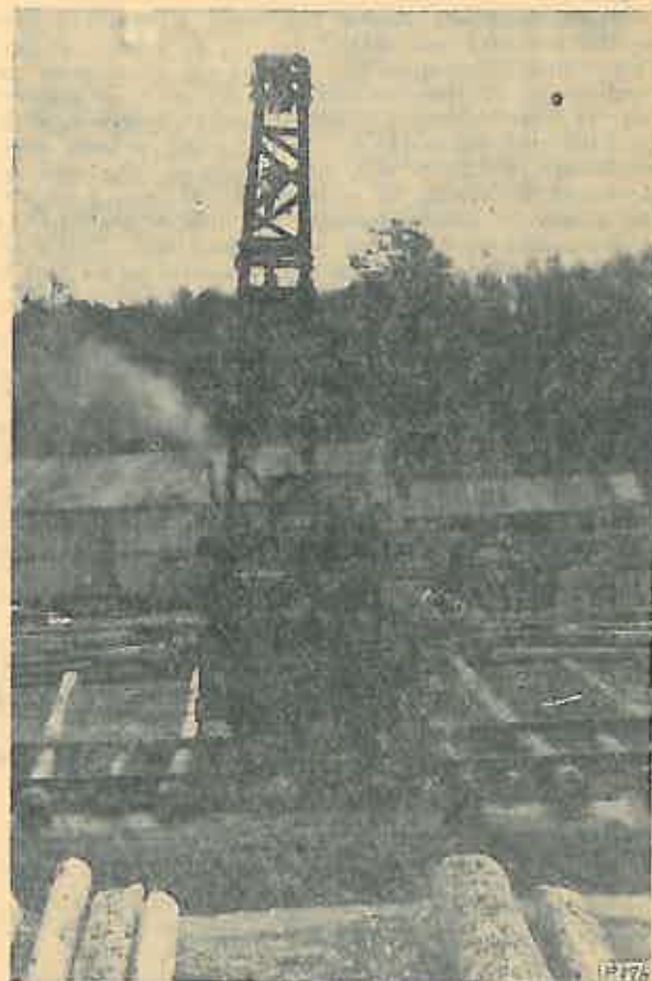
Fig. 1. Macara rulantă cu braț oscilant, confecționată la I. F. Reghin.
