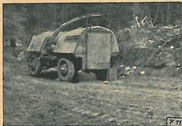
Fig. 5. Cisternă pentru repartizarea pe patul drumului a emulsiilor de asfalt sau de bitum.
