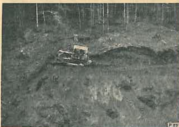
Fig. 2. Buldozer în lucru la drumul auto forestier Ghimbav.
