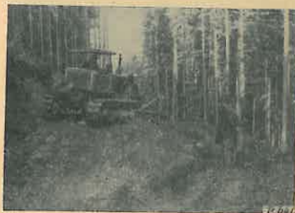
Fig. 3. Buldozer utilizat la defrișări
