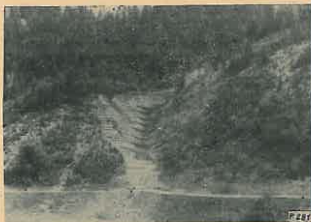
Fig. 2. Plantații de pini și gârdulețe executate pe versanți și un sistem de cleionaje sprijinite pe un gabion, amplasate pe fundul văii Bofului din perimetrul de corectare a torenților Bostanu — B. H. Bistrița.
