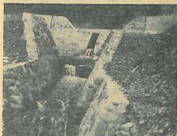
Fig. 7. Vedere generală din față a barajului-dren sistem prof. S. Rosić, executat experimental, în anul 1961, pe torentul Pietrosul, perimetrul de ameliorare Lerești-Muscel, Regiunea Argeș. (Foto: ing. Traian Mecoță, 1961)
