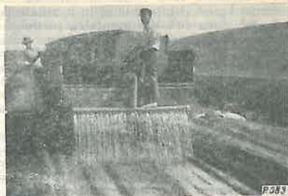
Fig. 8. Umidificarea amestecului prin stropire
