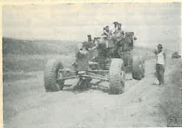
Fig. 6. Amestecarea pământului cu ciment cu motogrederul.
