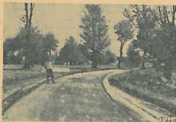
Fig. 5. Drum forestier auto de pămînt îmbunătățit, executat în condiții optime privind uscarea rapidă a corpului șoselei.
