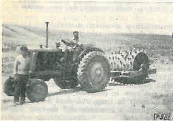
Fig. 10. Compactarea cu cilindrul piclor de oate.
