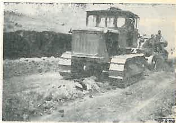
Fig. 4. Amestecarea pămîntului cu grederul (pămînt plus balast).
