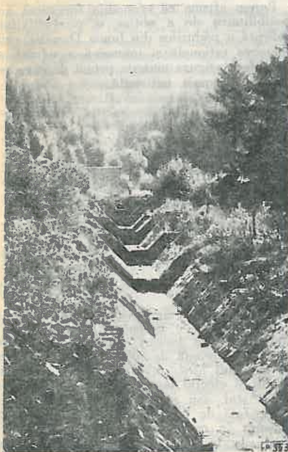
Fig. 2. Valea Bistriței - torențul Bostanu. Barajul - priză și canalul de evacuare a apelor la viituri mari.
