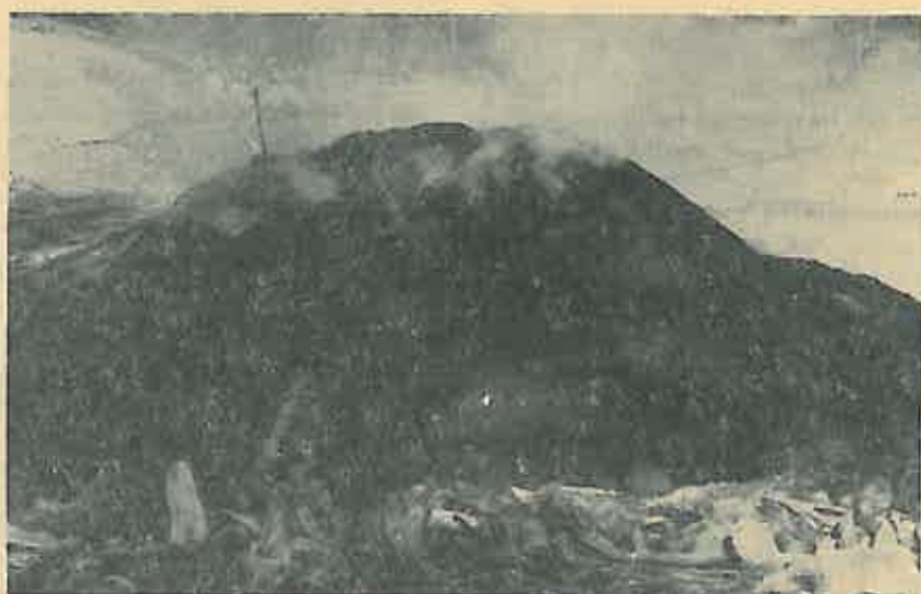
Boacă pentru manganizarea prin ardere a lemnelor din resturi de exploatare și lemn de foc în parchetul Brazi 438 P.R.P. I.F. Sighet.
