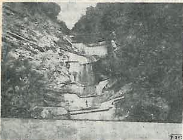
Fig. 6. Valea Prahovei — Valea Orășlii. Baraje de retenție și de consolidare a fundului albiei, construite susținut la panta de echilibru.
