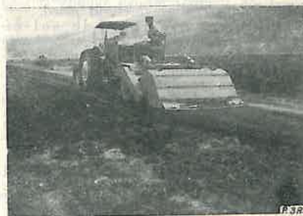
Fig. 9. Omogenizarea amestecului umidificat.
