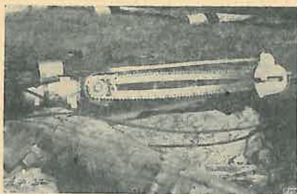
Fig. 1. Lama tăietoare a ferăstraielei electrice portative, după recondiționare.
