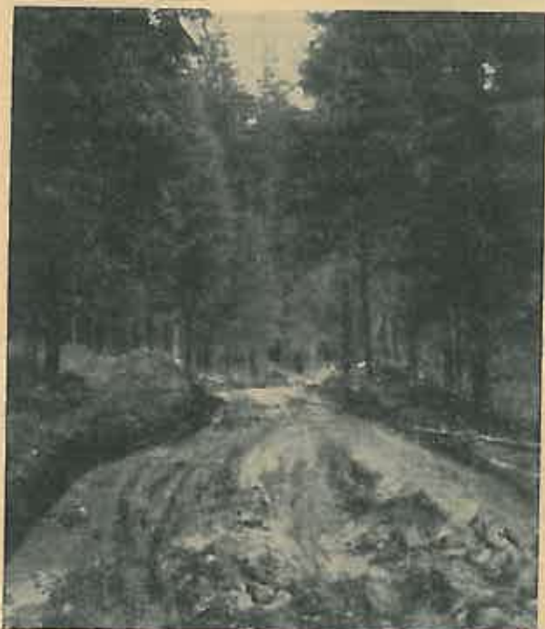
Fig. 6. Împietuire ușoară dată în exploatare pe perioada de iarnă și desfundată prin circulație; tronșon unde măsurile de luat sînt complexe, lățirea zonei defrișate avînd numai importanță secundară.
