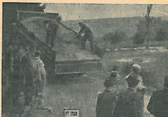
Fig. 4. Aplicarea stratului de criblură.
