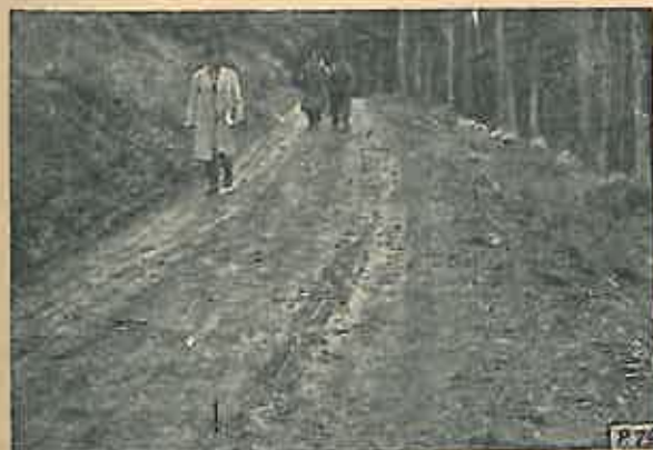
Fig. 6. Drum de pământ pentru transporturile auto, construit în anul 1961.
