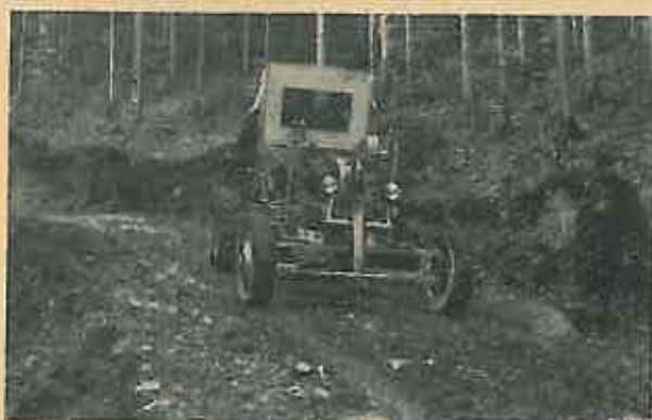
Fig. 6. Autogreder lucrind la împrăștierea și nivelarea pietrei sparte cu ocazia execuției suprastructurii
