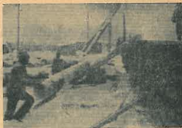
Fig. 8. Incărcarea prin rostogolire cu fir dublu și conducerea bușteanului.
