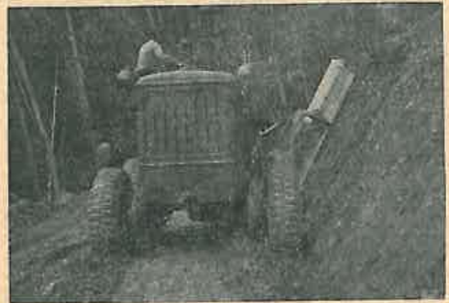
Fig. 3. Autogrederul D-144 în timpul lucrului la drumul auto forestier Ghimbav.
