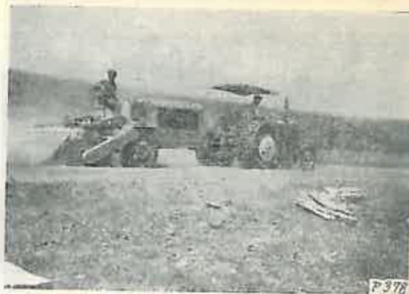
Fig. 3. Omogenizarea solului cu freza (pămînt plus balast).
