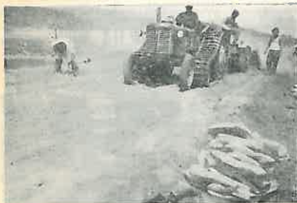
Fig. 7. Omogenizarea pământului cu ciment cu freza
