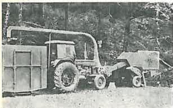
Fig. 5. Tocător pentru așchii tehnologice din crăci pe platforma de preindustrializare Răchitaș.
