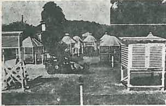
Fig. 3. Sere de sticlă ermetic închise, cu atmosferă controlată în care se fac testări privind gradul de rezistență la gazele toxice al speciilor lemnoase.
