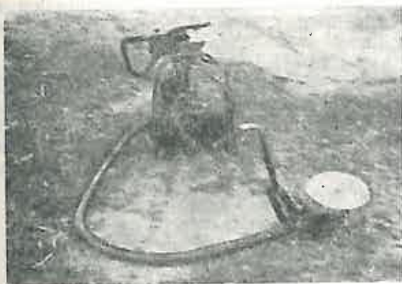
Fig. 3. Dispozitivul cositor G_2 ; se vede sistemul de transmisie.
