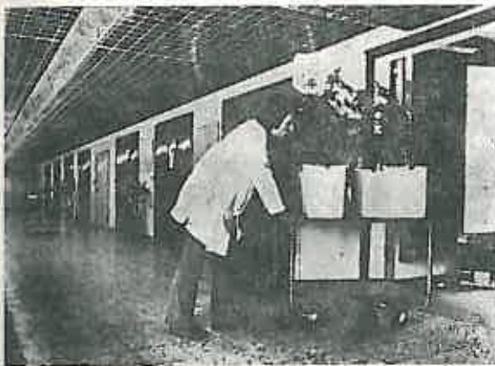
Fig. 4. Camere climatizate cu temperatură, umiditate și lumina reglate automat, în care se urmărește modul de comportare a plantelor lemnoase și ierbacee în vase de vegetație.
