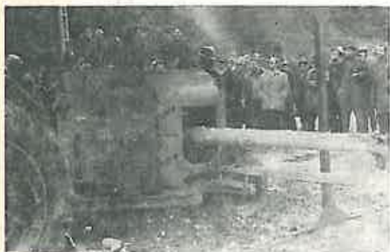
Fig. 4. Cojitor mecanic pentru rășinoase pe platforma de preindustrializare Răchitaș.
