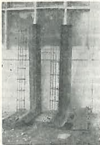
Fig. 3. Tipare metalice și armătura pentru elemente prefabricate modulate L 1,5 b: prototip cu secțiune trapezoidală, îmbinare moș-babă, folosit la zidurile de căptușire (foto: V. Voinea).
