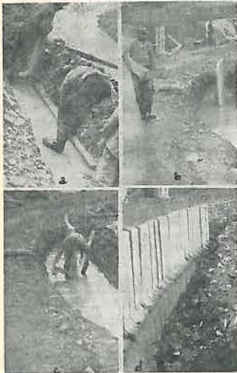
Fig. 2. Faze de execuție ale unui zid din elemente prefabricate modulate L 1 b: a) potrivirea grinzilor de reazim; b) transportul manual; c) montarea modulelor în condiții de infiltrații puternice; d) vedere asupra zidului realizat, înainte de monolitizare (foto: V. Voinea).
