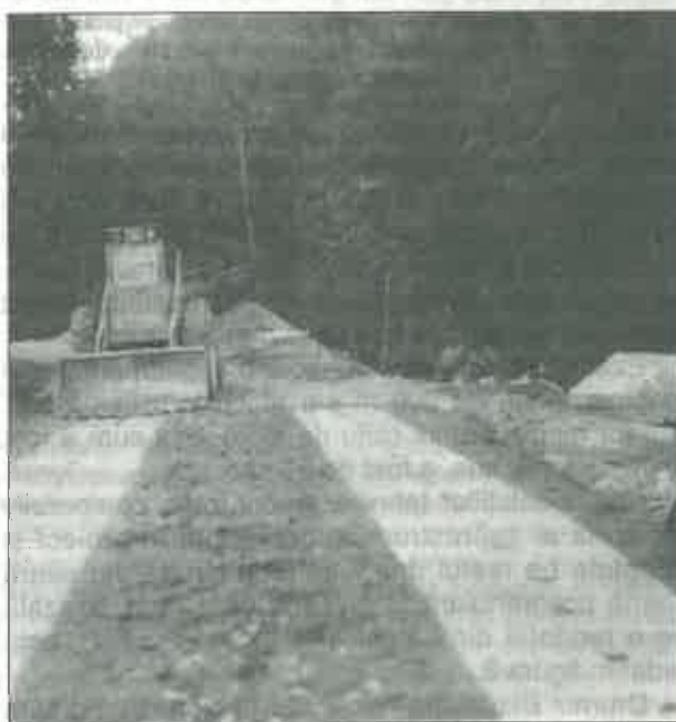
Foto 4. Așternerea balastului între dale și pe acostamente. (Placing the ballast between slabs and on road shoulders).
