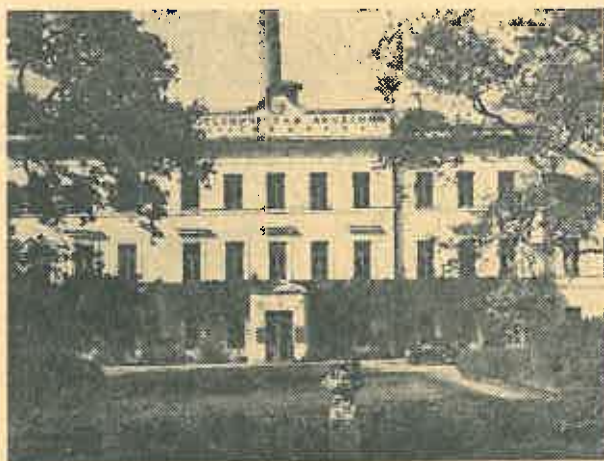
Fig. 1. Clădirea principală a Academiei Tehnice Forestiere „S. M. Chirov”
