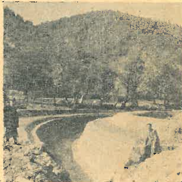
Fig. 7. După ce versanții au fost împăduriți și aluviunile au fost reținute în spatele lucrării de retenție, apele limpezi sunt conduse prin canaluri fără a mai putea pricinui pagube.
