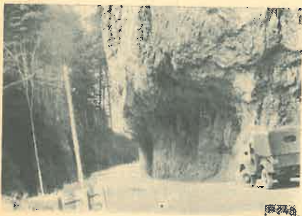
Fig. 3. Semiboltă. D.A. Olteț 1
