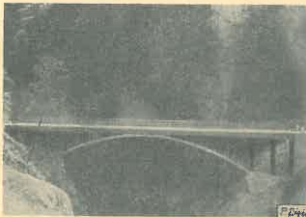
Fig. 1. Pod 1 L = 28 m Scărița-Olteț, Șantier Tg. Jiu
