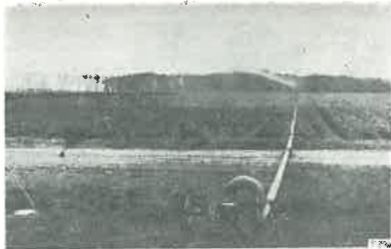
Fig. 4. Aripă de ploaie cuplată la conducta principală. Aspersor în funcțiune. Foto: Ing. Dumitrescu Traian
