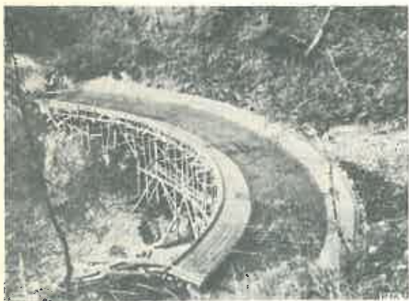
Fig. 5. Viaductul Oticu în curs de execuție ( l = 32 m, h = 12 m, în curbă).
