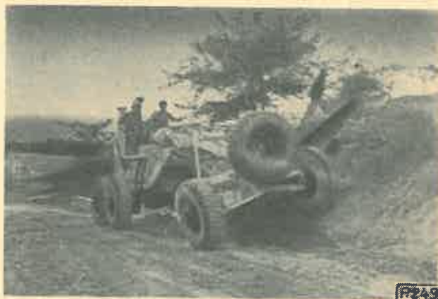
Fig. 4. Autogreder lucrînd la taluzări. D.A. Piscuri-Tojești
