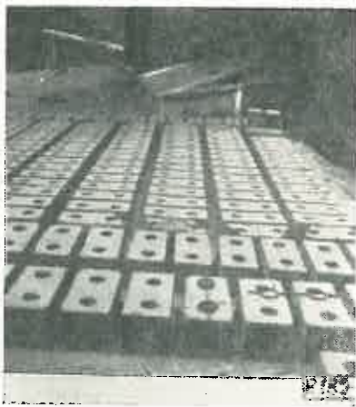
Fig. 1. Blocuri din beton cu goluri de armare, pentru utilizări multiple (ziduri de sprijin, culee de poduri, fundații la clădiri etc.), executate la șantierul-școală Brașov.
