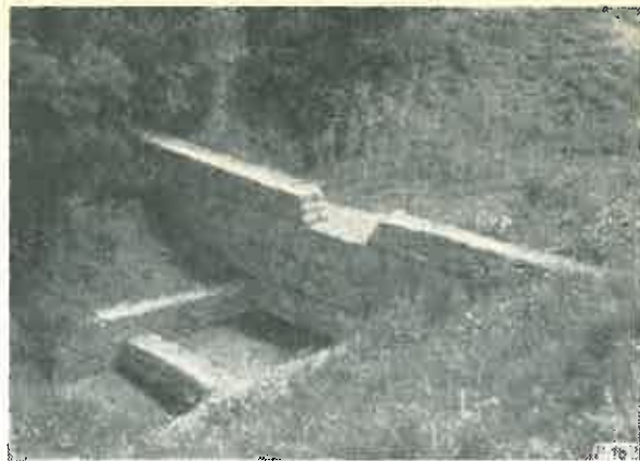
Fig. 2. Perimetrul Poiana (pîrui Icului). Ansamblu de lucrări format din gabion, butășiri pe aterisamente și plantații de maluri.
