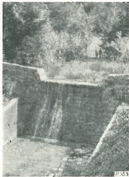
Fig. 3. Perimetrul Găureni-Valea Satului. Baraj pentru retenția materialelor aluviuare care erau transportate spre calea ferată.
