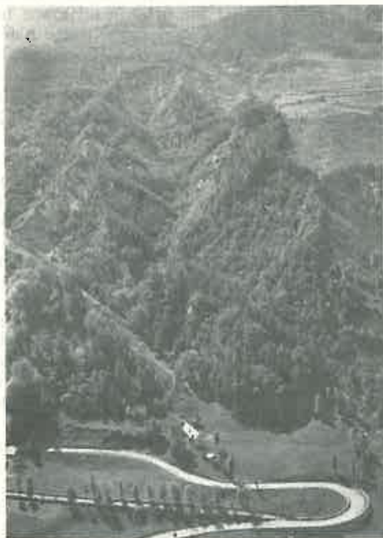
Fig. 2. Valea Barèges (Hautes Pyrénées). Torentul „Le Pontis”. Aceeași vedere din figura 1 luată în iunie 1945, când după executarea lucrărilor de corecție începute în 1902 torentul a fost stins.
