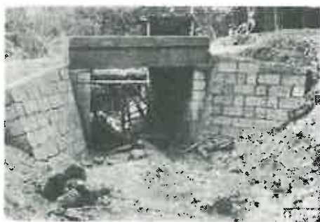
Fig. 10. Podeț din blocuri de beton simplu, cu goluri și armătură din fier-beton (drum Timiș-Brașov).
