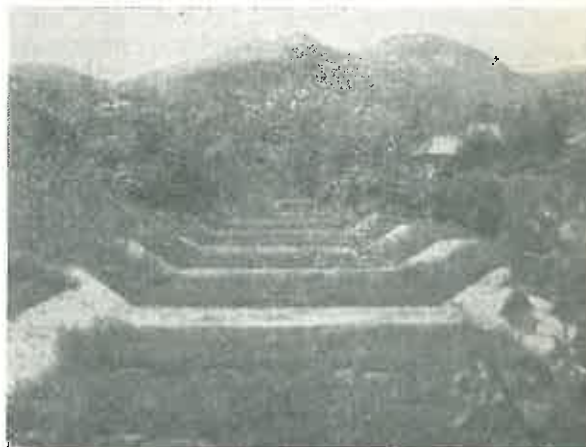
Fig. 2. Perimetrul Sălcuia Arieș. Lucrări în treimea inferioară a formației Pintești.
