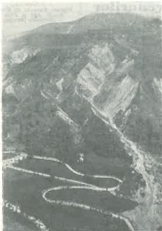
Fig. 1. Valea Barèges (Hautes Pyrénées). Torentul „Le Pontis”. Vedere de ansamblu în septembrie 1896, după distrugerea vechiului drum de către conul de dejecție al scourgerilor de lavă din 1882—1885.
