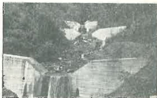
Fig. 5. Torentul din Nant-Trouble — serie domeniială Ugine (Savoie). Baraje din beton armat, aterisate rapid. Pe maluri, altădată goale, s-a dezvoltat vegetația forestieră.
