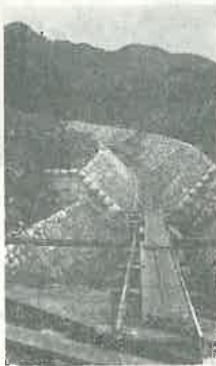
Fig. 8. Torrentul „Le Nant Noir”-Savoie, Alpii din Nord. Canal în trepte cu brieruri afuiabile, praguri transversale și pereuri din zidărie cu mortar.
