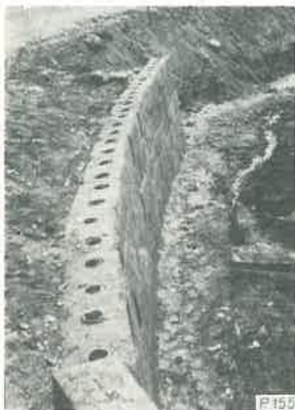
Fig. 12. Zid de protecție din blocuri prefabricate de beton, cu goluri, având armătura din țevi PVC (drum Timiș-Brașov).
