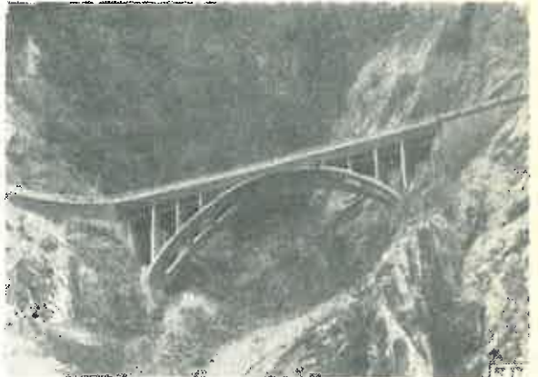
Fig. 6. Vedere de perspectivă a unui viaduct.
