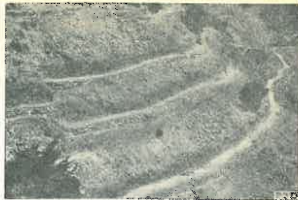
Fig. 5. Terase susținute de banchete de zidărie uscată, pe terenuri excesiv erodate, cu piatră curgătoare pe versanți (perimetrul Andreiașu).
