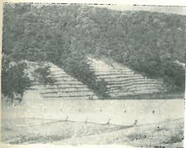
Fig. 6. Lucrări de corectare — torentul Curejdu (Piatra-Neamț).
