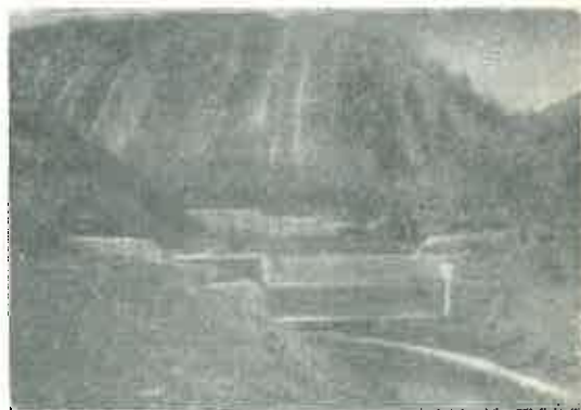
Fig. 2. Îmbinarea lucrărilor hidrotehnice cu cele vegetative pe pîrîul Colacu, perimetrul Colacu. Se observă necesitatea degajării unui culoar în vegetația de pe aterisament, în dreptul deversoarelor.
