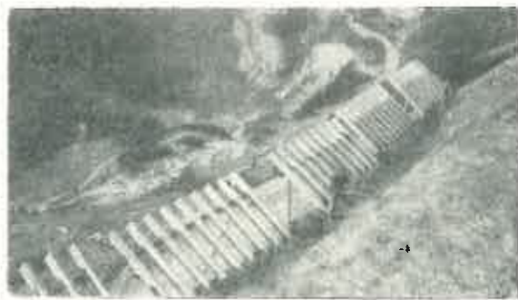
Fig. 1. Comuna Aroches (Haute-Savoie): greble de protecție contra avalanșelor la Flaine.
