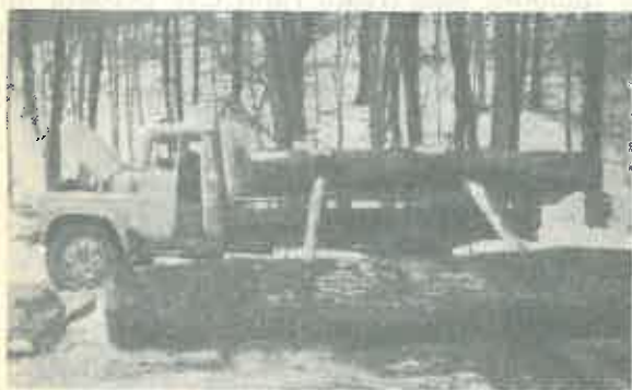
Fig. 5. Încărcarea primului rând de bușteni cu dispozitivul montat pe autocamionul ladă.
