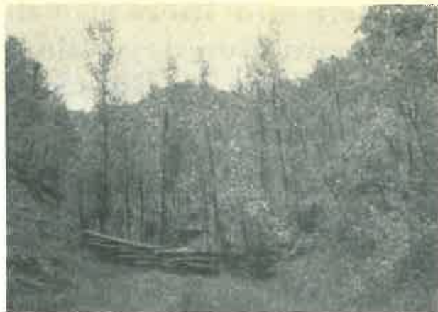
Fig. 3. Lucrări din lemn intrate în vegetație.
