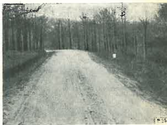
Fig. 5. Comportarea corespunzătoare a drumului din macadam neprotejat.
