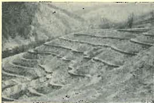
Fig. 3. Terenuri excesiv erodate pe care s-au efectuat terase sprijinite de gârdulețe. Între terase, plantații în gropi obișnuite (perimetrul Andreiașu).
