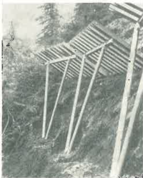
Fig. 3. Comuna Chamonix-Argentières (Haute-Savoie); greble de protecție contra avalanșelor la Lognan (vara).
