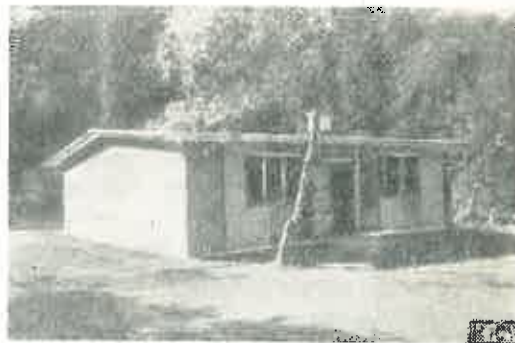
Fig. 3. Cabană forestieră construită din blocuri prefabricate pe bază de deșeuri lemnoase la drumul Valea Calului-Timiș.
