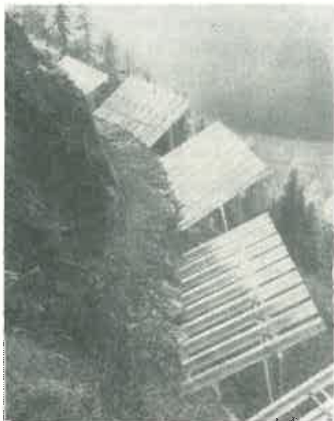
Fig. 2. Comuna Chamonix-Argentières (Haute-Savoie); greble de protecție contra avalanșelor la Lognan.
