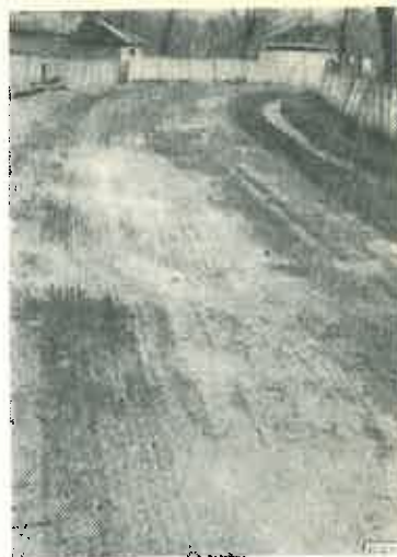
Fig. 4. Aspect al drumului cu formații de gropi în macadam.
