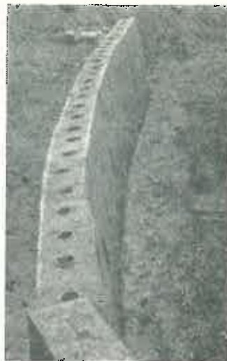
Fig. 2. Zid de sprijin din blocuri de beton cu goluri armate cu țevi de masă plastică, executat de șantierul-școală Brașov la drumul forestier Valea Calului-Timiș.
