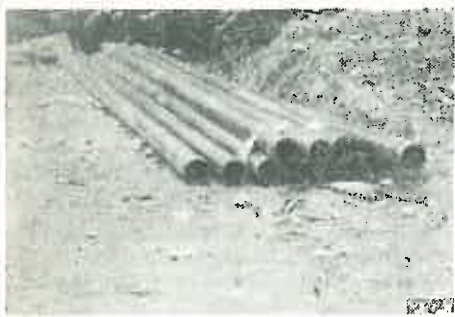
Fig. 11. Tevi PVC tip mediu pentru armarea zidăriei, din blocuri de beton cu goluri (drum Timiș-Brașov).
