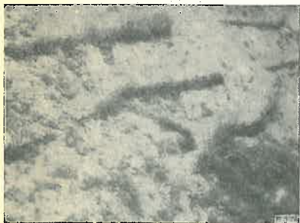
Fig. 4. Gârdulețe executate primăvara din nuiele verzi de salcie, care au lăstărit, formînd cordoane verzi (perimetrul Andreiașu).
