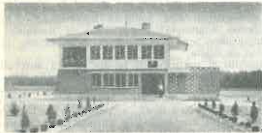
Fig. 1. Clădirea din pepiniera Zăval.
