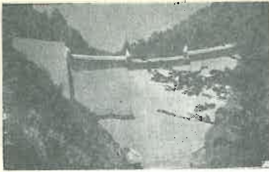
Fig. 7. Bazinul Onc (Haute Garonne-Pryenées Centrales). Baraj de sedimentare din beton înalt de 25 m, volum 4 400 m 3 . Vederea din aval cu detaliile de construcția deversorului și coronamentului.
