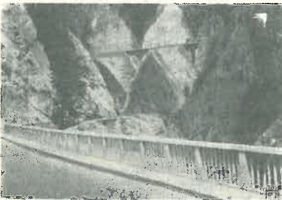
Fig. 4. Vedere panoramică a drumului în două sectoare.
