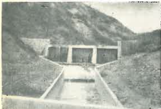
Fig. 3. Baraj din grile pe contraforți, executat pe pârâul Măgura — bazinul hidrografic Năruja (proiectat de ing. N. Gologan).
