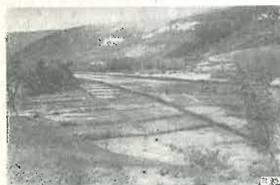
Fig. 4. Vedere generală asupra sistemului de lucrări folosit.
