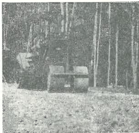
Fig. 5. Cilindrarea unui nou drum forestier.
