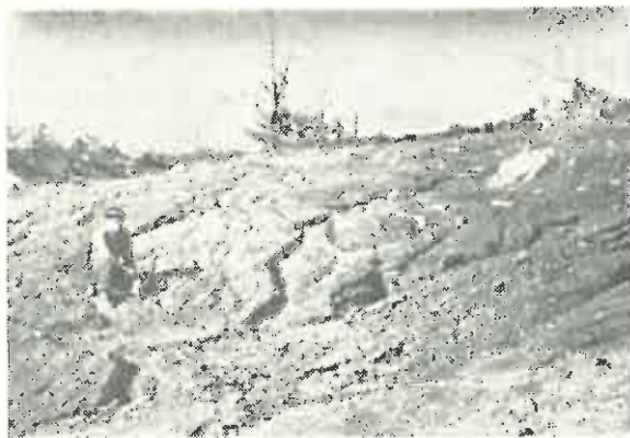
Fig. 6. Procese de șiroire și rigolare în terenuri crude argiloase pe taluze.
