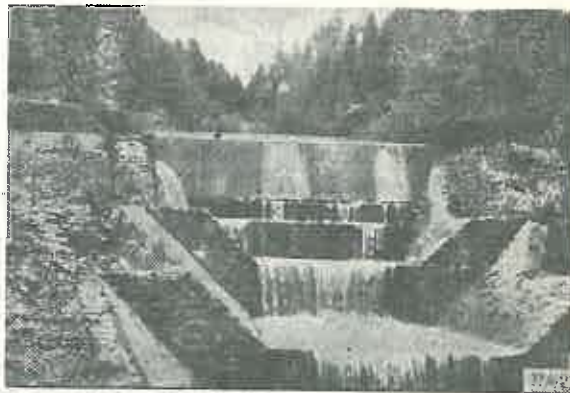
Fig. 3. Complex de lucrări de corectare, executat pe torentul Unghia-Mică.
