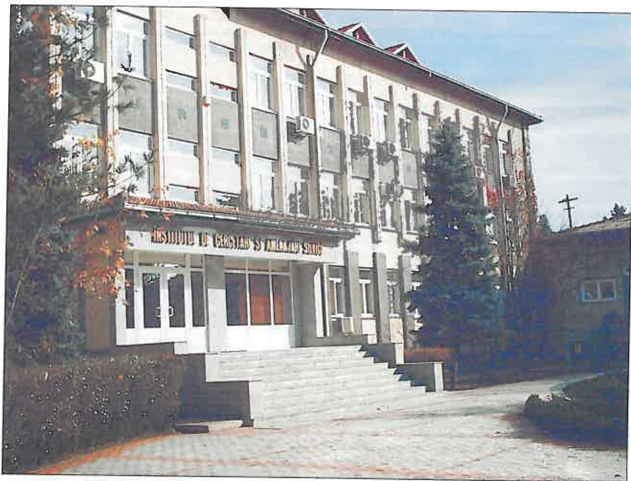
Sediul actual a ICAS (1976, după transferarea acestuia din Șoseaua Pipera 46 în Bulevardul Eroilor 128, Voluntari - Ilfov
