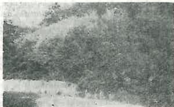
Fig. 3. Același taluz debleu în anul 1984 (plantația de anin a acoperit complet și a consolidat foarte bine taluzul).
