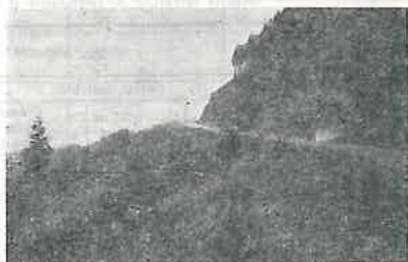
Fig. 5. Același taluz rambleu în anul 1984 (taluz consolidat cu vegetație forestieră tânără, pin și molid de 8—10 ani, și vegetația ierbacee instalată natural).
