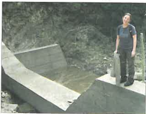
Foto 1. Lucrări de corectare a torențurilor la O.S. Târgu Ocna (D.S. Bacău)
