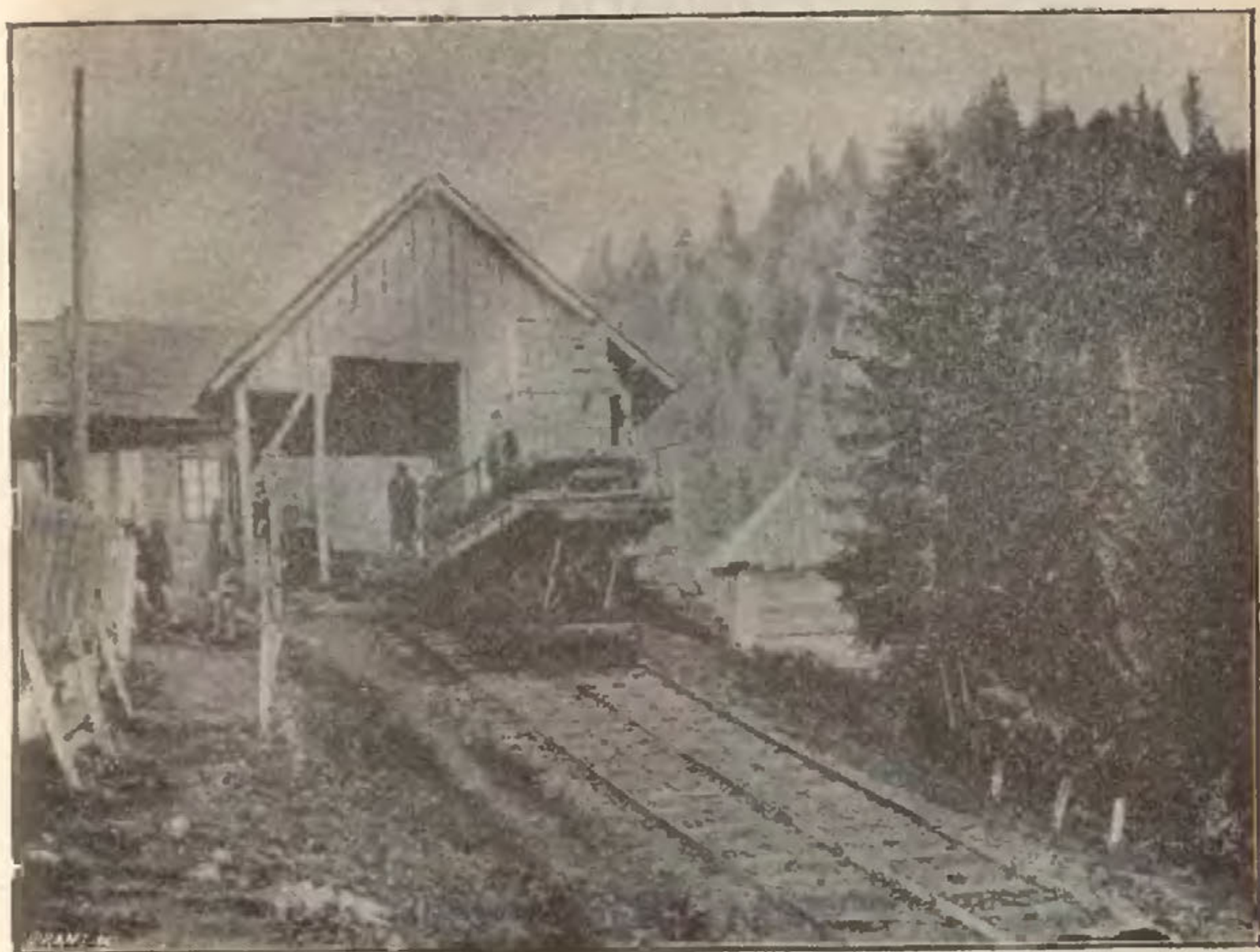
Vederea funicularului cu vagonul din stațiunea de încărcare.
