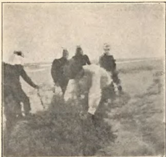
Executarea cordoanelor cu crăci de pin maritim.
