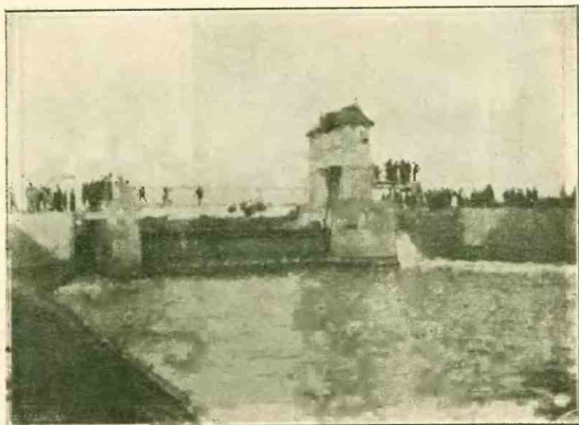
Ecluzele de pe canalul Bega.
